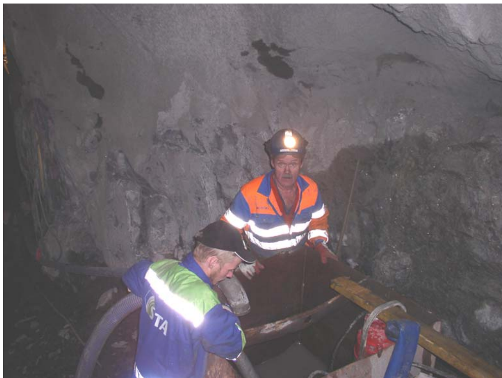
Foto 9.1.5. Slamsugning ur sedimentationskar - Namntall
