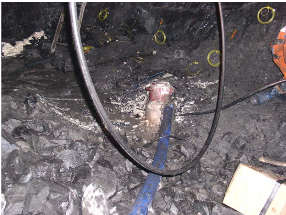
Foto 8.1.6. SSE spill på och nära dränvattenpump – Björnböle
