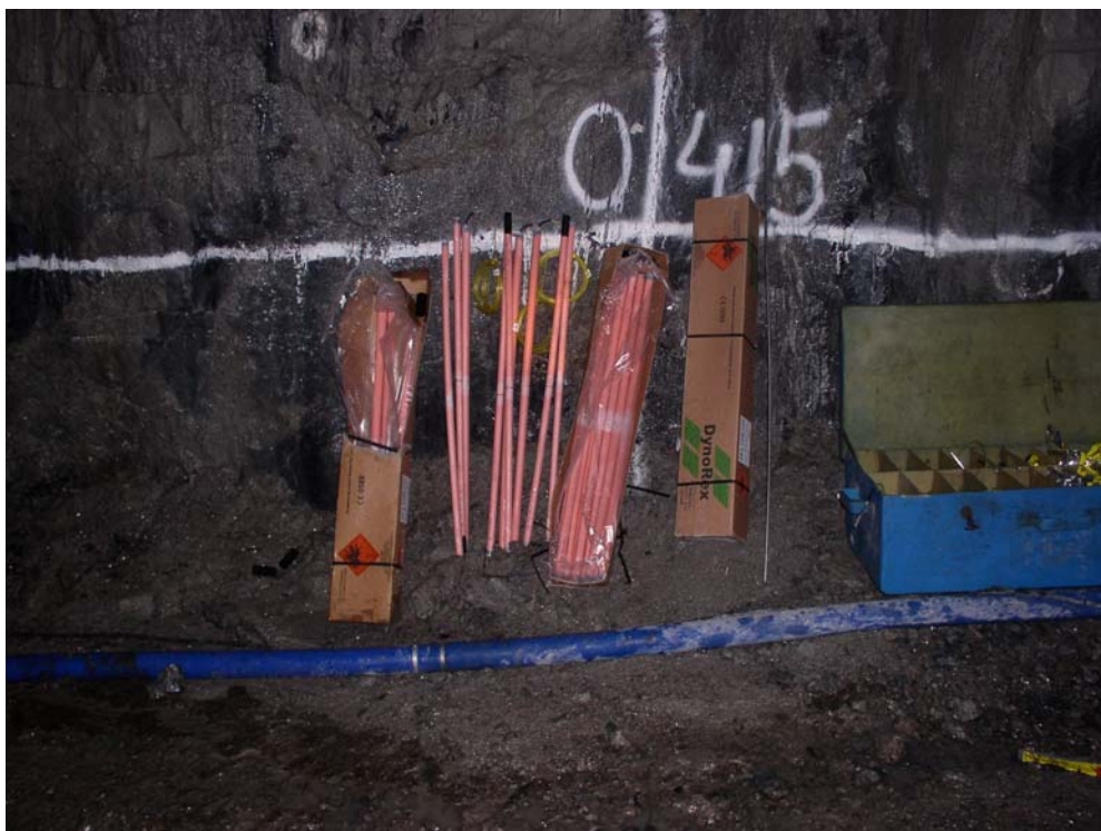
Foto 11.3. Patronerade sprängämnen – Tunga lådor vid laddning av ANFO salva.
