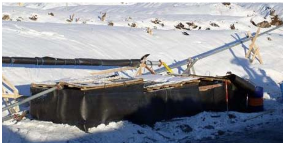
Sedimentationskar utanför tunnelmynningen. Flödesriktningen är från vänster till höger på bilden.
